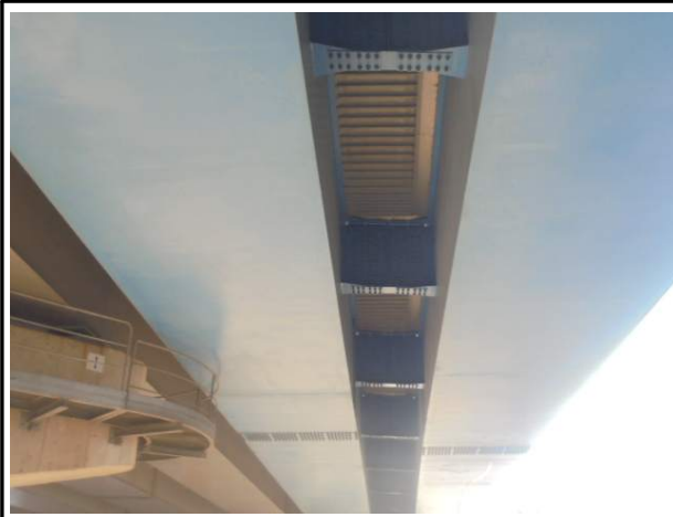
거더 외부 상태양호
